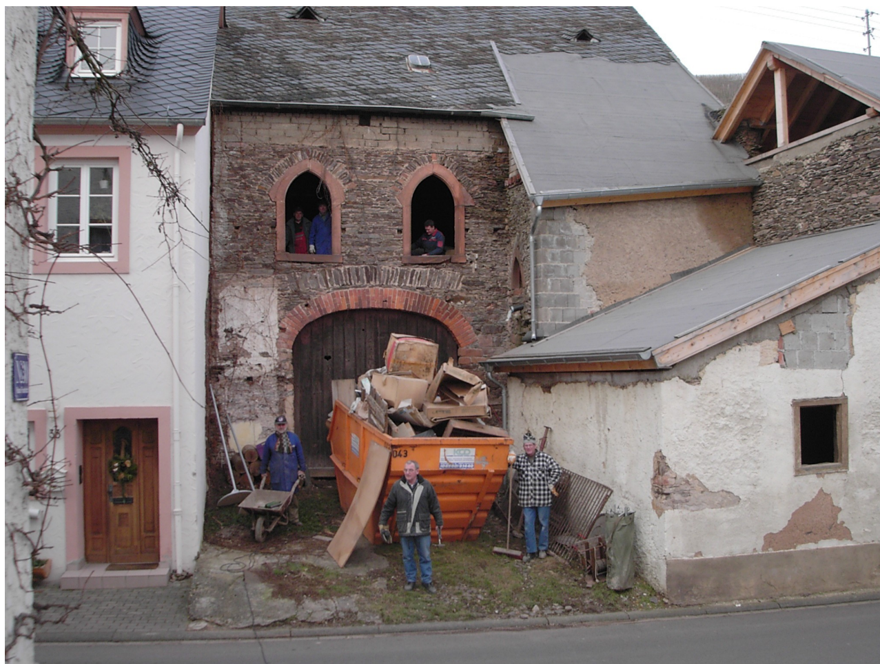
Vereins Scheune mit dem neuen Dach, Räumaktion
